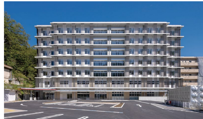
完全竣工した「鹿教湯三才山リハビリテーションセンター」
