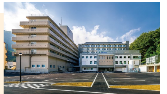
北側アプローチ全景
